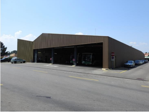
Façades Sud + Est
