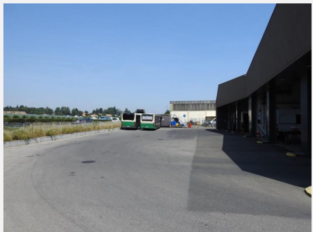
Aire de circulation Nord
